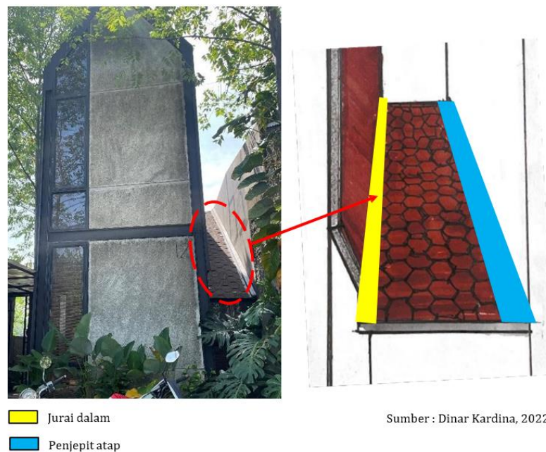
Gambar 8. Jurai Dalam Pada Material Bitumen Asphalt "Gro House"
