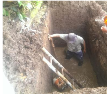
Gambar 5 Rembesan air pada tanah galian
