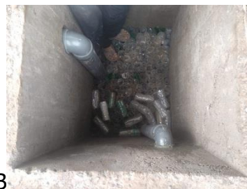
Gambar 8 A. Perakitan bekas botol minuman, B. Penyusunan di dalam Bak Filter
